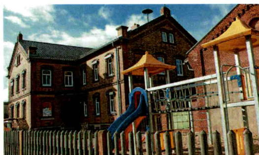
Im Eingangsbereich der kommunalen Kita Haus der kleinen Spatzen in Oppurg stehen etliche Sanierungen in diesem Jahr an.
