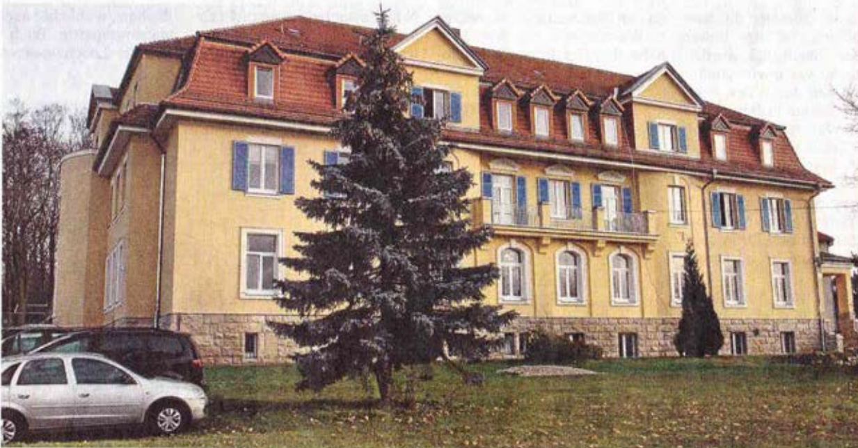
Das Kinder- und Jugendheim in Ranis erstrahlt nach der Außensanierung in neuem Glanz.
